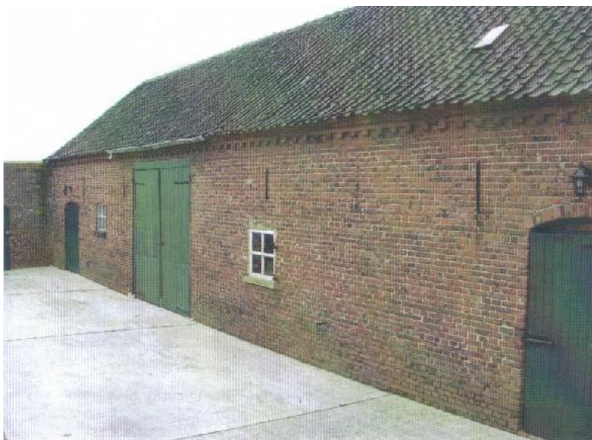
Foto: bijgebouw ten behoeve van nieuwe woning 2 en 3 gezien vanaf binnenplaats
